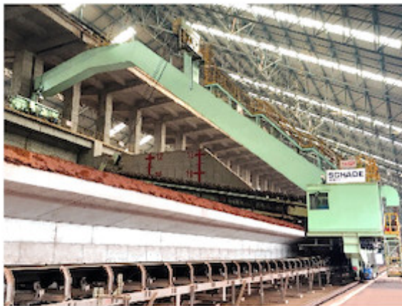
SCHADE Halbportalkrater für Baosteel im Betrieb (Foto SCHADE)
